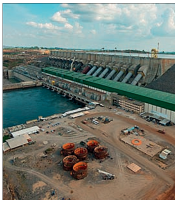
5. Vue de la centrale électrique de Belo Monte pendant la construction.
